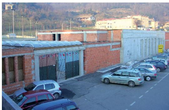
Le pareti dello stesso stabile non sono intonacate e tutta la struttura subisce il logorìo degli elementi atmosferici con l'acqua che penetra nelle murature.
